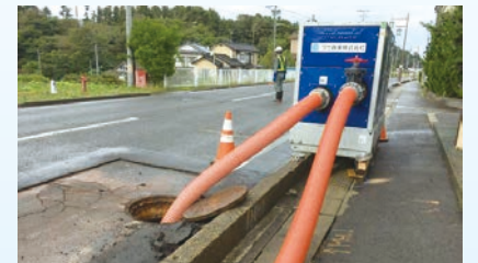
災害対応から補修工事まで幅広く活用
