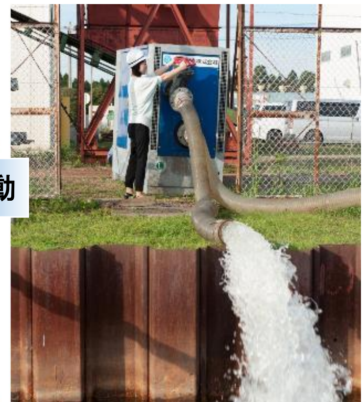
ゲリラ豪雨等による洪水時の仮設排水例
