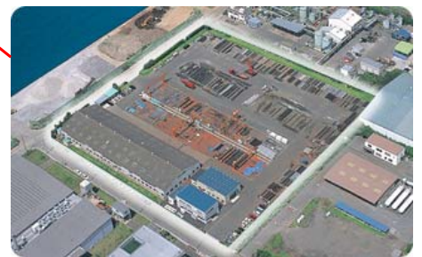
袖ヶ浦工場 (敷地面積20,000平米)
