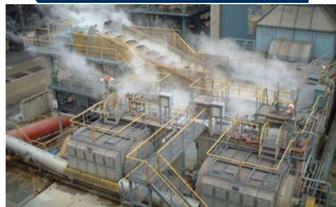
水砕スラグ製造設備
