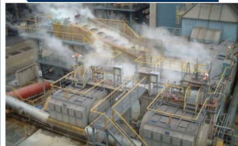
水砕スラグ製造設備
