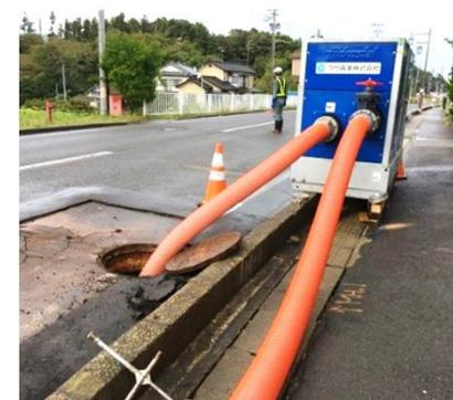
災害時のインフラ復旧、下水道管などの補修工事、下水処理場・工場の緊急排水に活用
